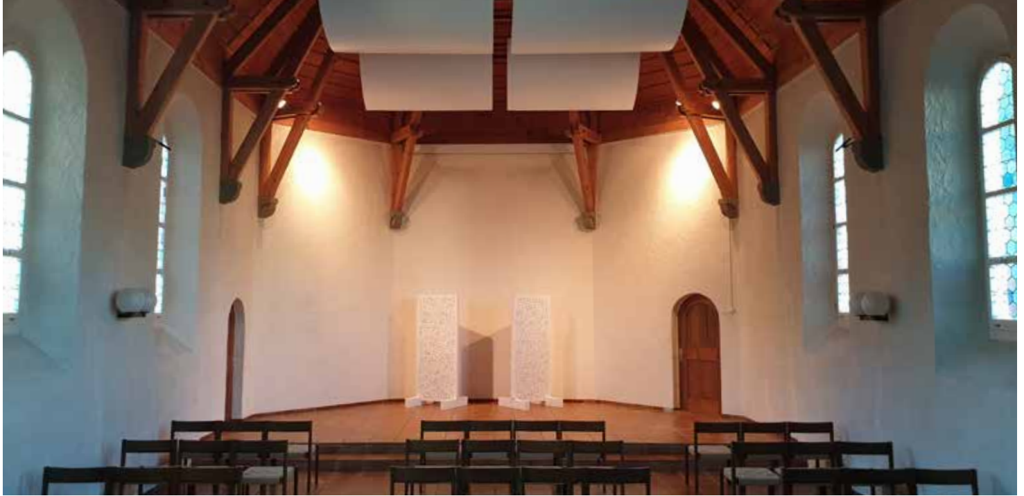
Vier leicht gekrümmte Panels an der Decke sowie zwei senkrechte Panels im Chorbereich optimieren den Klang in der KulturKapelle9. Bild: zvg
